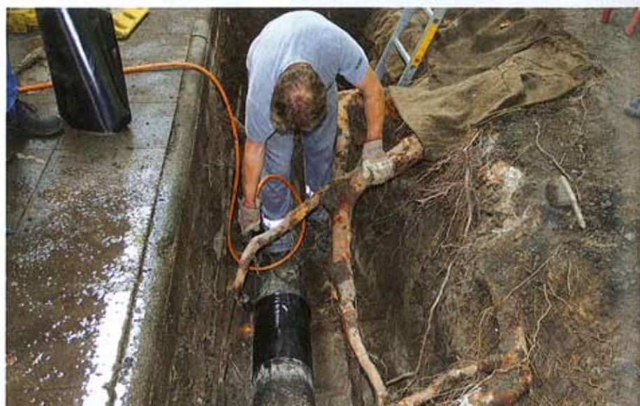
Reparaturarbeiten an geschädigter Gashochdruckleitung: Zunächst werden die Rohre und Wurzeln freigelegt, um die Rohre auf Leckagen untersuchen zu können. Sodann wird die Dernoton-Fertigmischung eingefüllt und verdichtet.
